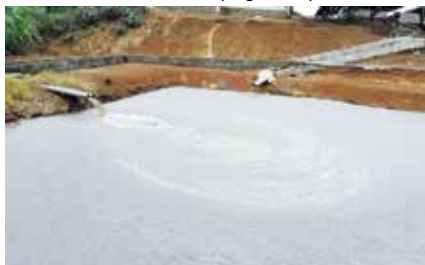
Figura 1. Laguna de tratamiento en granja porcina (VIOGAZ, 2011).
