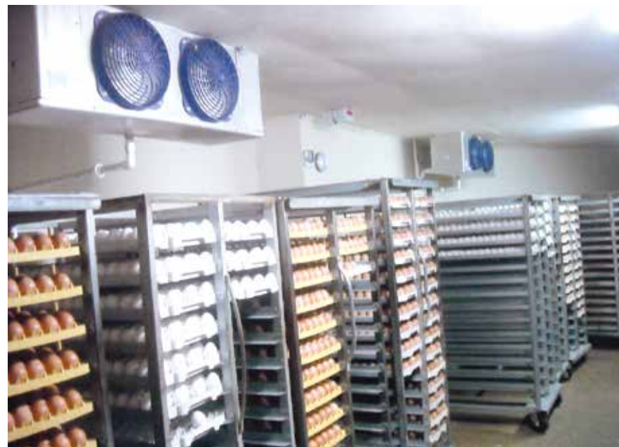
Figura 3. Sistema de enfriamiento y espacios entre los "buggies" para fomentar la ventilación en los cuartos de almacenamiento de huevos.
