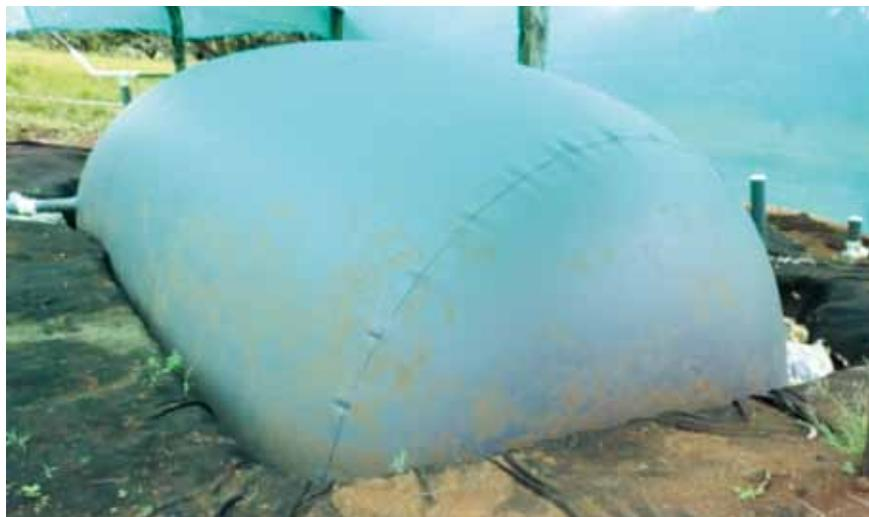
**VIOGAZ®** con capacidad de 42.000 L. con 16 días de tiempo de retención hidráulica, se está logrando una remoción de 76,6% de la carga contaminante del "agua residual", ahora visto como un biofertilizante.
