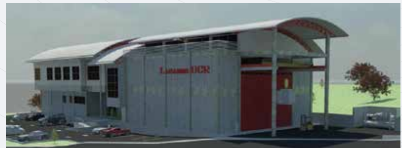
Edificio de Laboratorios para LANAMME UCR
